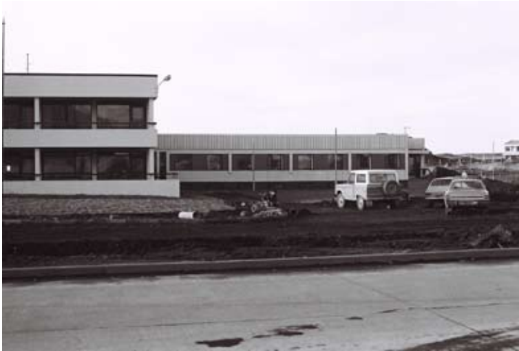
Hér er búið að byggja kjallara og fyrstu hæð viðbyggingar í austur frá upphaflegri byggingu. Í greininni kallað fyrri hluti annars áfanga. Árið er 1975.
